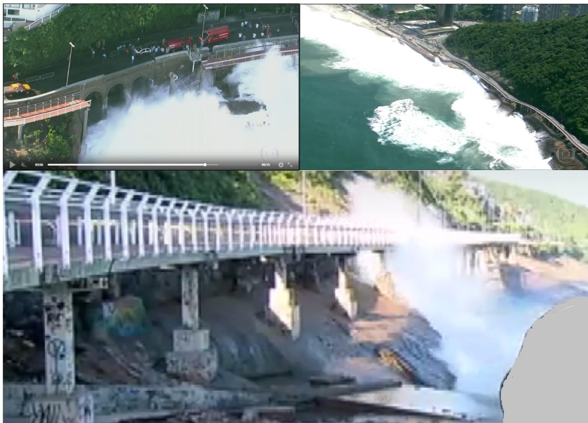
Figura 33. Outros segmentos da ciclovía que são vulneráveis à ação de ondas. Note que o jato ascendente no lado direito da imagem à esquerda é causado pela deflexão de um pequeno muro de contenção de rochas soltas que fica abaixo. Fotos acima: https://globoplay.globo.com/v/4972654/ . Foto maior abaixo: http://noticias.r7.com/jornal-da-record/videos/ciclovía-que-desabou-no-rio-apresentava-rachaduras-antes-da-inauguracao-23042016
