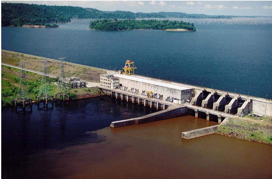
UHE Balbina – elevado impacto ambiental
