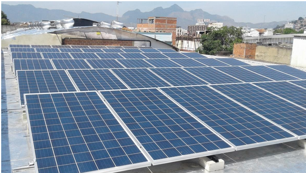
Centro Cultural Bela Maré (projeto e instalação EDB)
